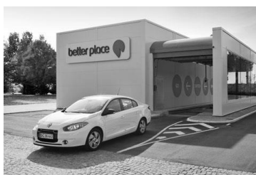
Рис. 5 Станція заміни АКБ
