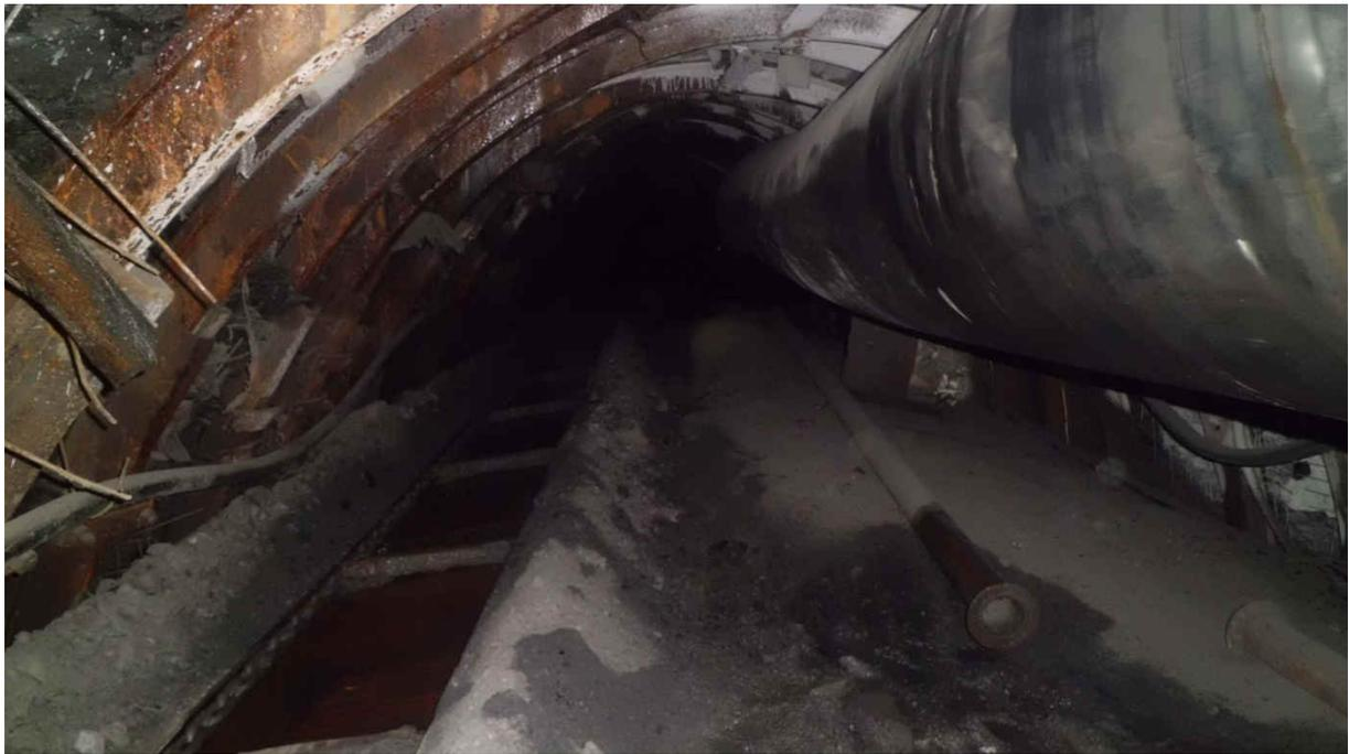
Рисунок 1 - Вентиляционный штрек 2 восточной лавы пласта I<sub>1</sub> ПКЗ-ПК4. Высота поднятие почвы 1,5-1,8м, состояние рамной крепи удовлетворительное, состояние затяжки – удовлетворительное, капеж воды с кровли по левой стороне и по центру.
