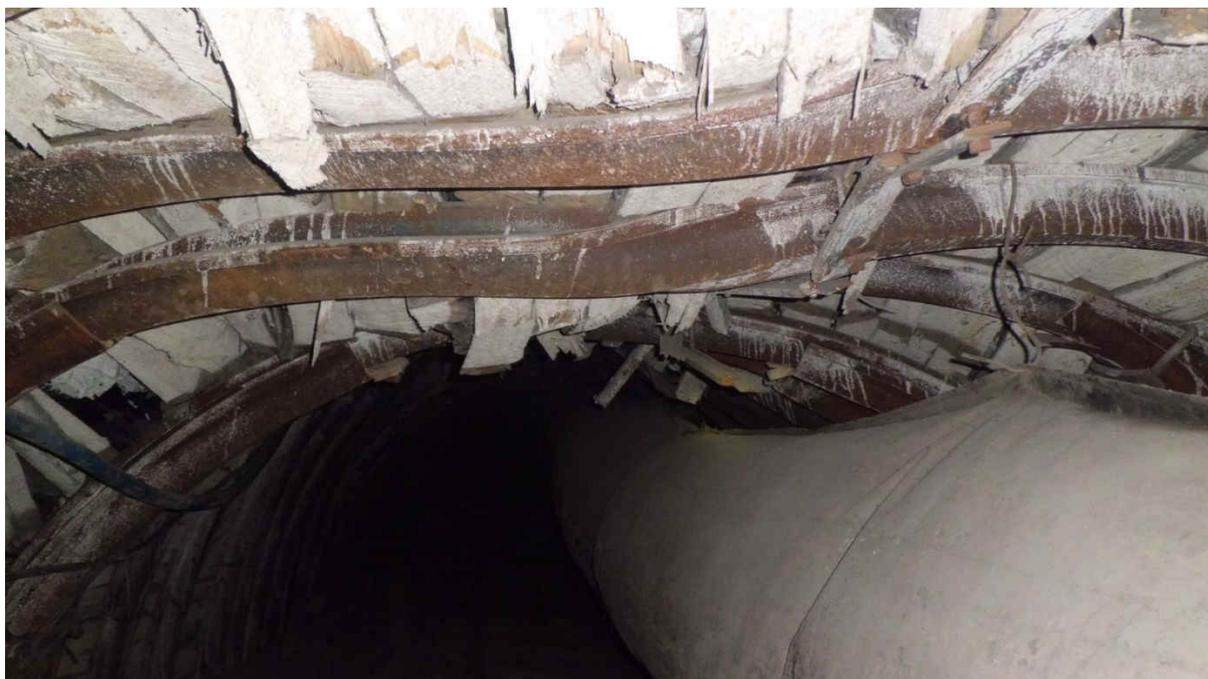
Рисунок 3 - Проявление деформаций верхняков металоарочной крепи. Крепь КМП-АЗК/15,3, шаг установки рам 0,5м
