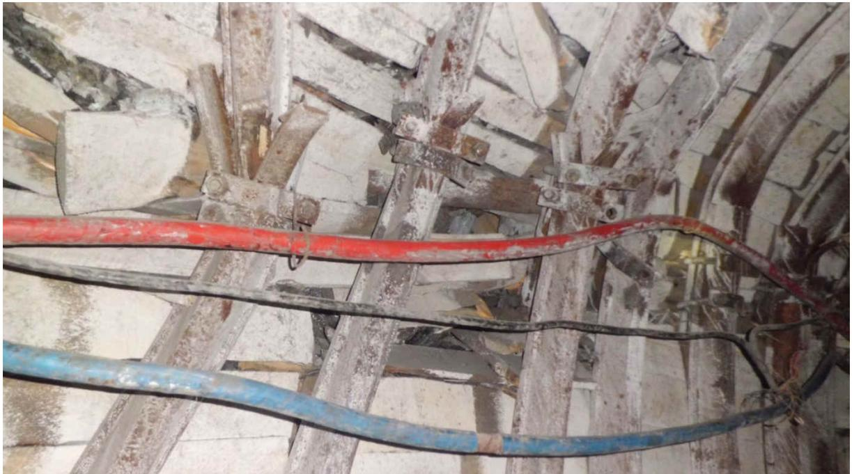
Рисунок 2 - Проявление деформаций стоек металоарочной крепи. Крепь КМП-А3К/15,3, шаг установки рам 0,5м
