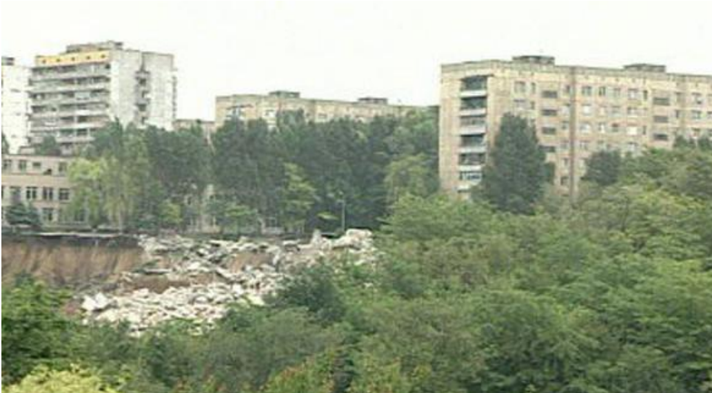
Рис. 1. Зсув на ж/м Тополя у м. Дніпропетровську (зсувний схил складений товщею обводнених лесових порід)
